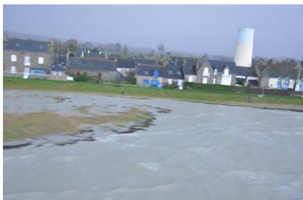
Cherrueix : château d'eau ; impact de l'absence banc coquillier
