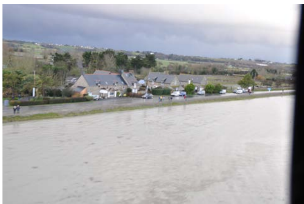
Les Nielles : la digue provisoire en eau
