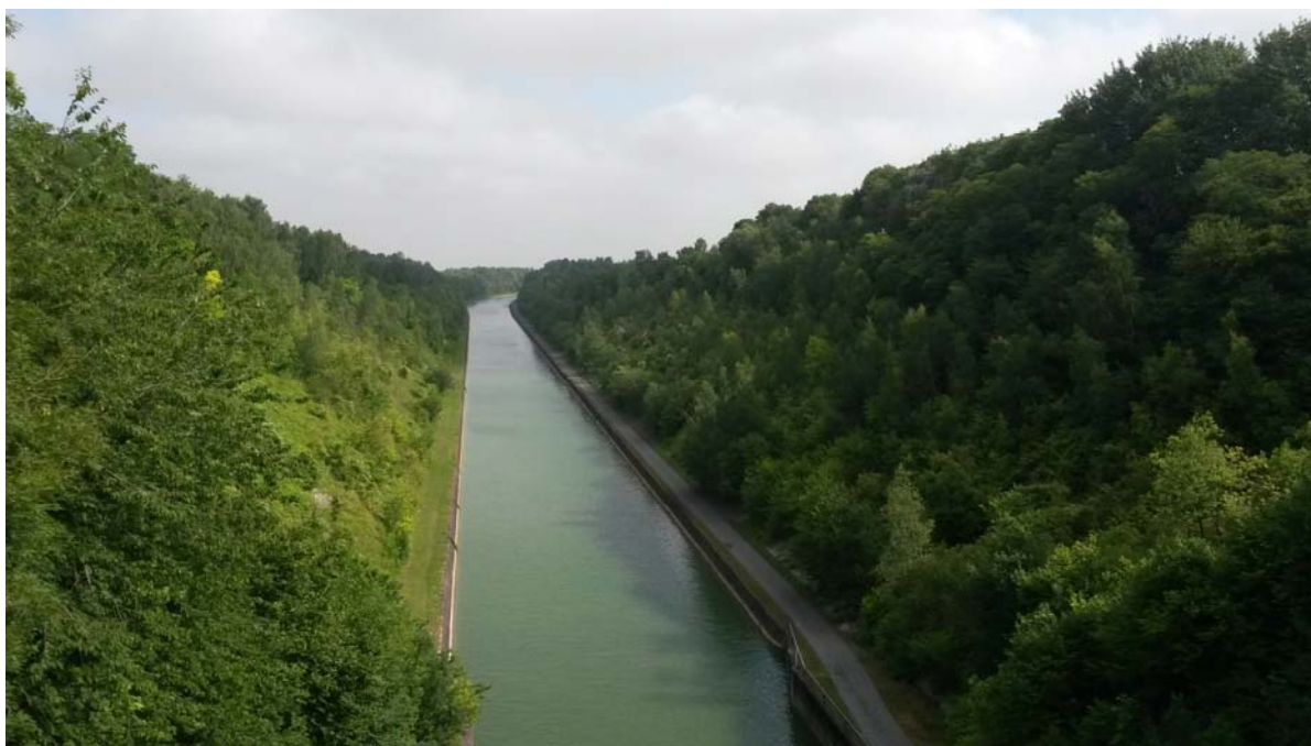
Photo de la tranchée d'Havrincourt prise par les rapporteurs
