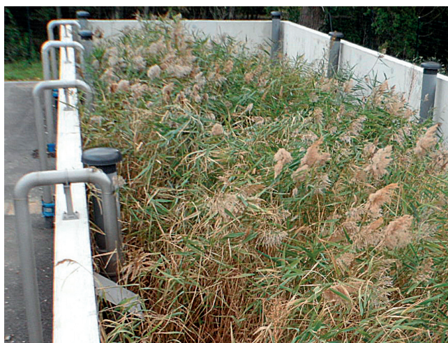
Canalisation d'alimentation inox, plaque déflectrice et cheminée d'aération munie d'un chapeau
