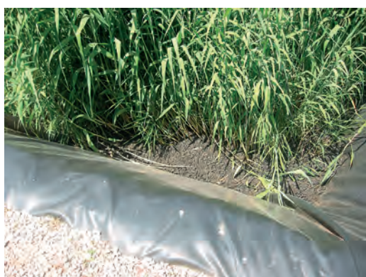
Densité de roseaux suffisante pour appliquer une charge de fonctionnement nominale (de l'ordre de 250 tiges/m 2 )
