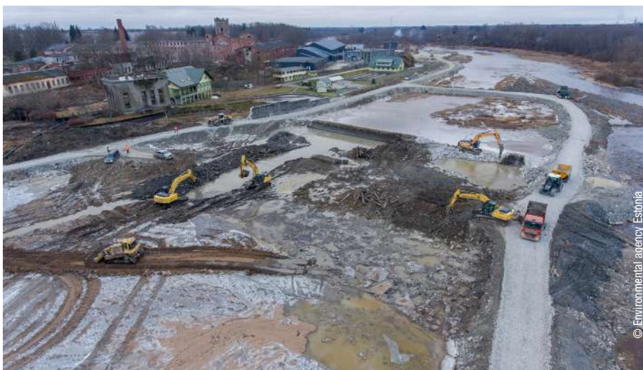
Effacement en cours du barrage Sindi, large de 151 mètres et haut de 4.5 mètres situé sur l'axe de migration du saumon, rivière Parnu en Estonie, décembre 2018.
