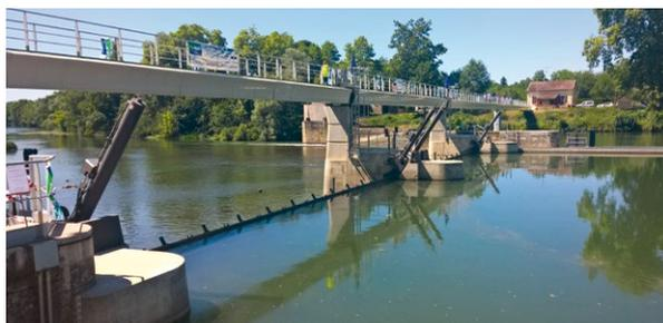
Une passe à poissons de 11 bassins permet désormais le franchissement du barrage d'Apremont en Haute-Saône, un ouvrage de plus de 2 m de haut. La continuité écologique est restaurée et le fonctionnement de la rivière s'améliore.
