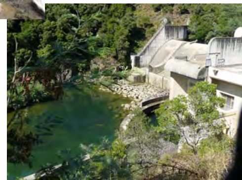
Barrage tignet sur la Siagne à Tanneron
