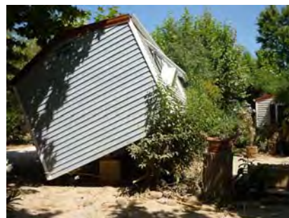
Dégâts suite aux inondations (camping)
