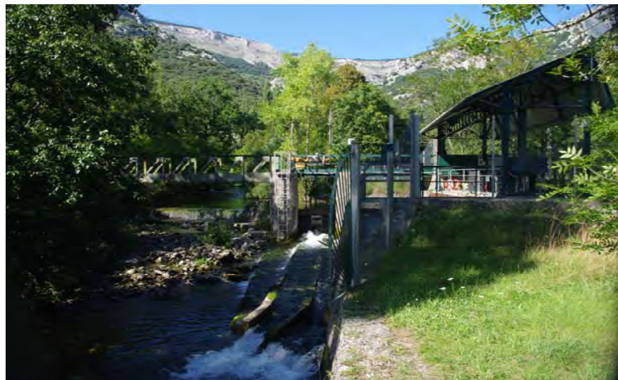
Prise d'eau EDF d'Escragnoles (Haute-Siagne)
