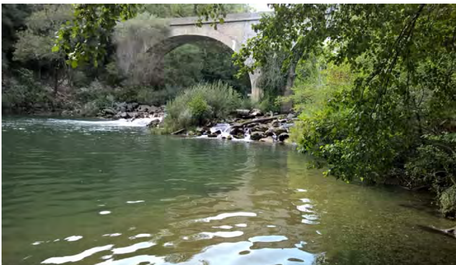
Pont sur la Siagne à Auribeau
