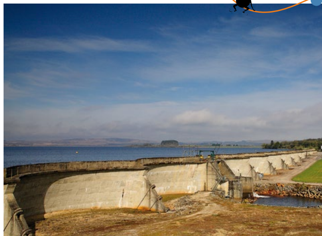
Le barrage de Nestavel
