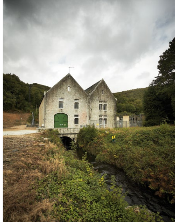
Usine hydroélectrique de Saint-Herbot
