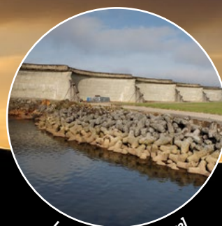
Le barrage de Nestavel
