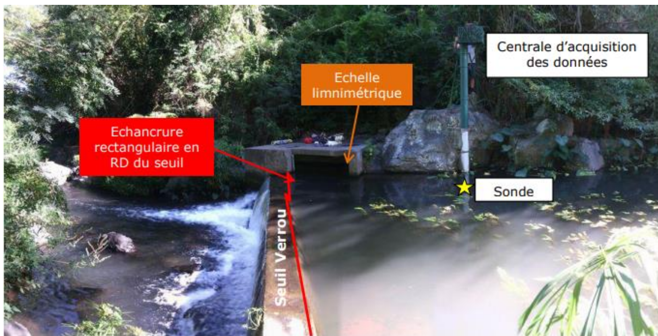
Figure 7 : Emplacement de la station hydrométrique 15057 - Ravine Saint-Gilles en 2018
