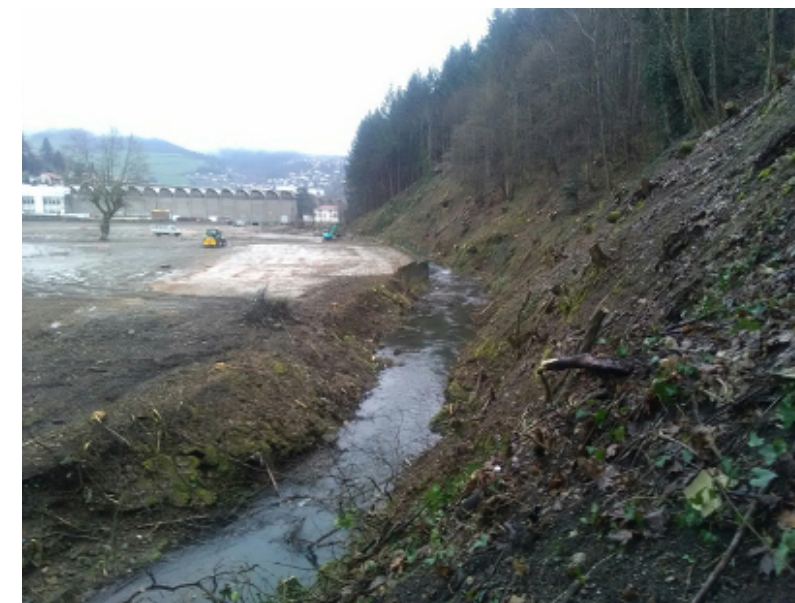
La zone de travaux après les abattages préalables
