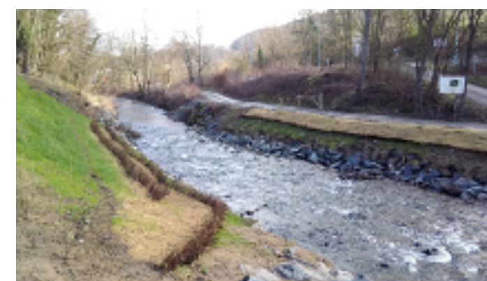
La Brévenne restaurée après suppression du gué
