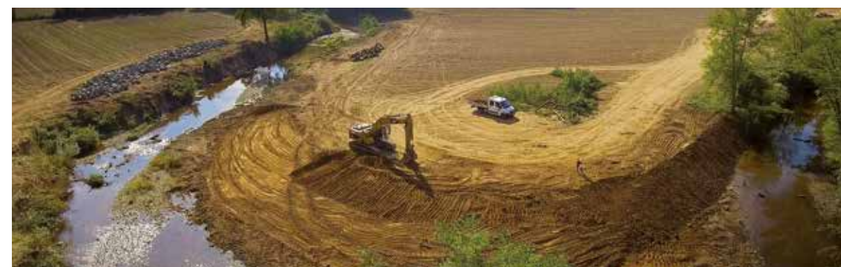
terrassement aux Fours à Chaux
