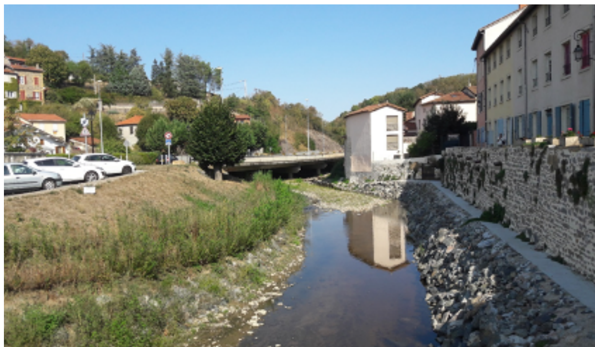
La Turdine après les travaux
