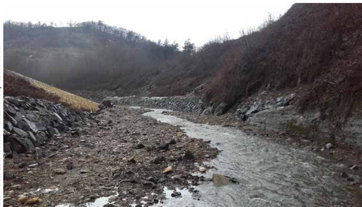
La Brévenne dans le secteur de la Patte après le chantier
