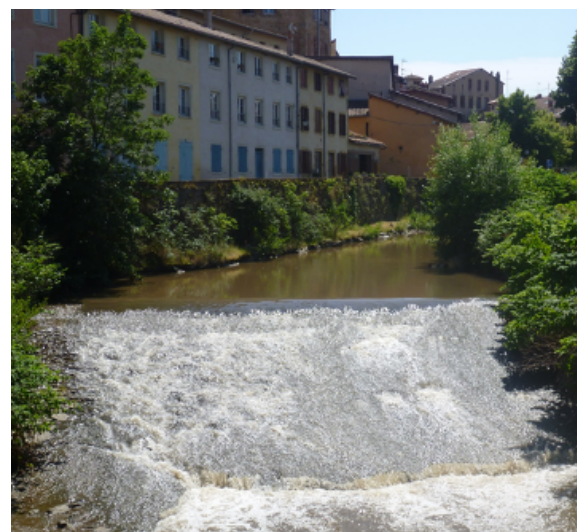
seuil Sapéon avant travaux
