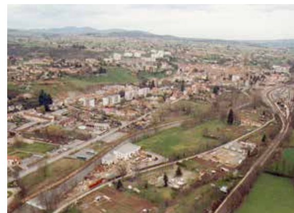
Le quartier du Bigout avant travaux
