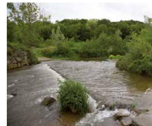
Seuil des Fours à Chaux avant dérasement
