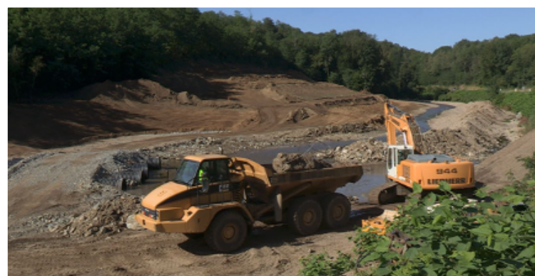
Le dérasement en cours
