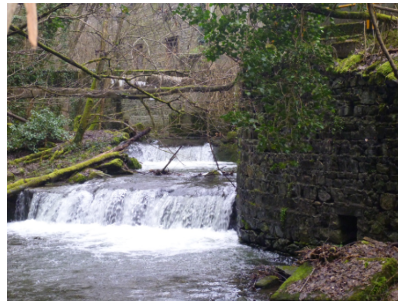
Seuils existants qui seront supprimés pendant les travaux
