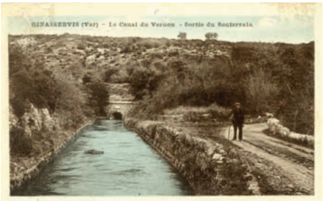
Sortie du souterrain à Ginasservis.
