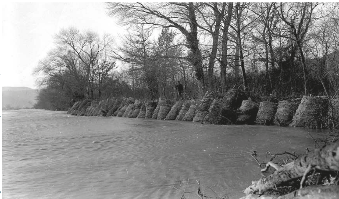
Gabions de protection, Mallemoisson.
