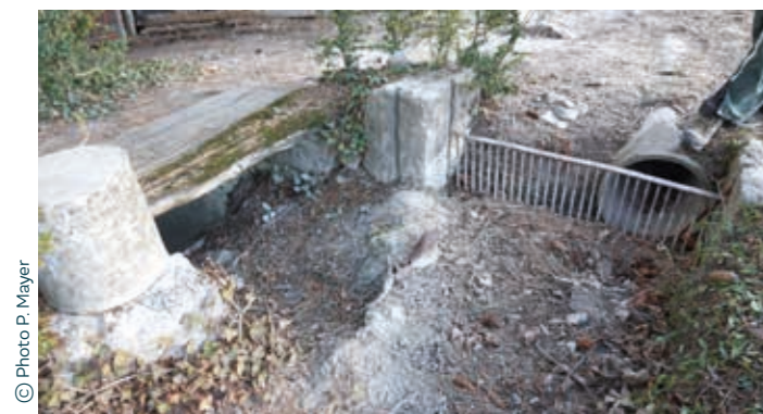
Canal de l'usine Arnaud et déversoir régulateur à l'entrée de l'usine. Les encoches correspondent à l'emplacement de la martelière.
