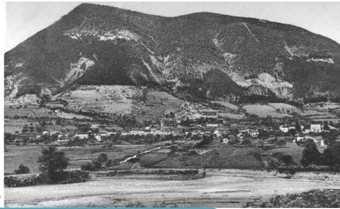
Vue de la digue dans les années 1920-30.
