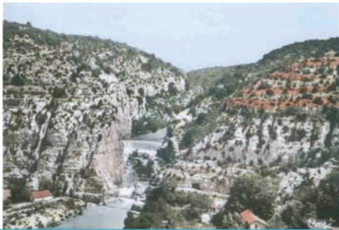
Voisinage entre les prises d'eau du canal du Verdon, du canal du moulin à son aval, et captage de la source alimentant le village (maison abritant la machine élévatrice en rive droite) au débouché des gorges de Baudinard.
