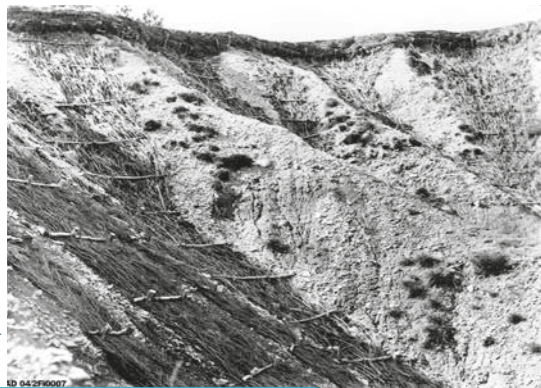
Aménagement de clayonnages.
