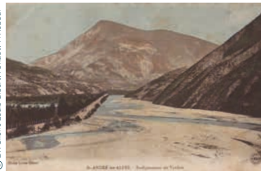
Route-digue à l'emplacement actuel du lac de Castillon.
