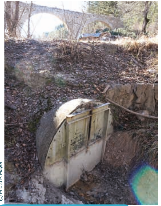
Nouvelle prise du canal des usines suite aux crues de 1994.
