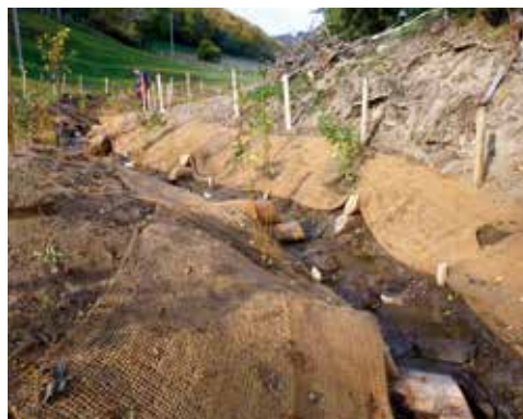
Restauration des berges du Cartelier à Rontalon.
