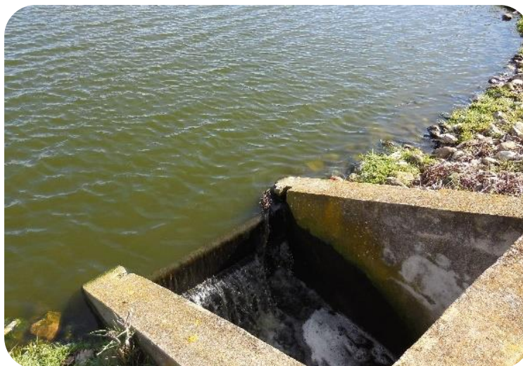
Surverse à hauteur réglable et amovible (planches dans un rail - inspirée du « moine ») ©SATESE- CG81
