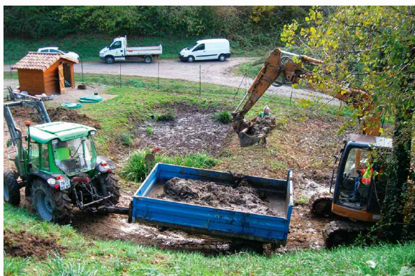
Figure 14. L'envasement des ZRV nécessite un curage.
