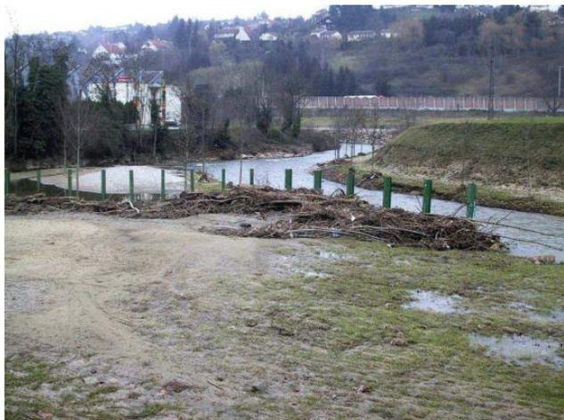
Fig 10. Peigne à embâcle sur la Bourbre (Piégay et al, 2004)
