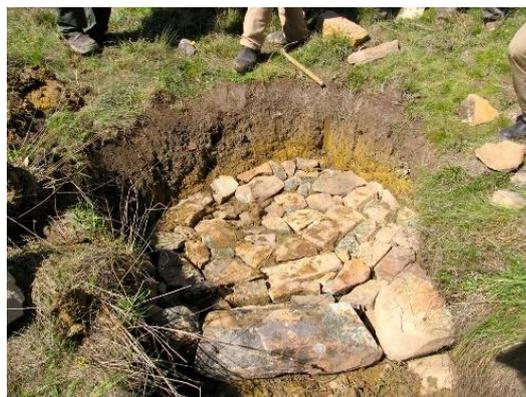
Fig 22. Fabrication d'un Zuni Bowl (@milkwood.net)
