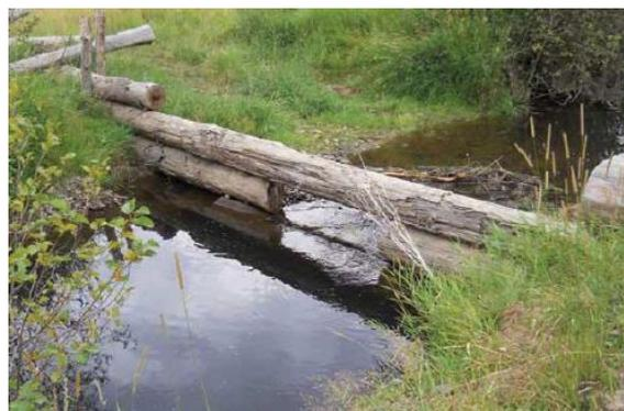
Fig 23. Structure d'obstruction à l'écoulement 'flow choke' (DeVries et al, 2012)
