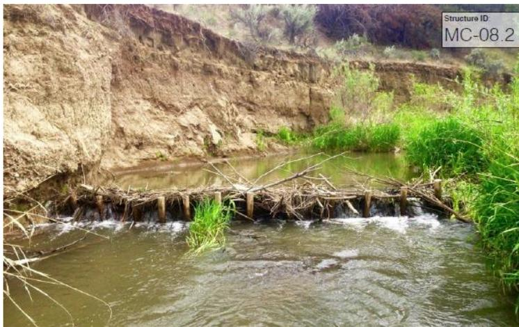
Fig 25. Exemple de structure LTBP installée sur un secteur incisé de la rivière Bridg Creek (Weber & Bouwes, 2017)
