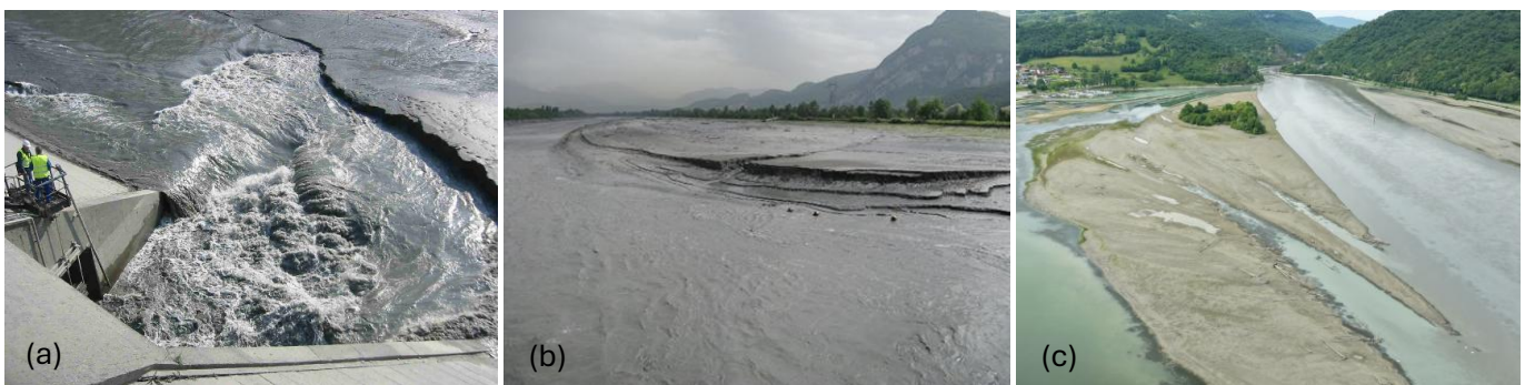
Figure 1 : Exemples de particules fines déposés dans des réservoirs : (a) bassin de Longefan (Arc) lors d'une chasse en 2008 (b) banc de la retenue de St Egrève (Isère) lors d'un abaissement, (c) banc de la retenue de Belley lors d'un abaissement (Rhône).
