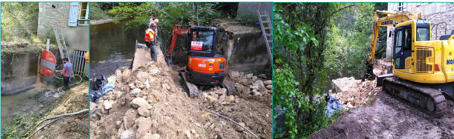
Découpe du mur-seuil
