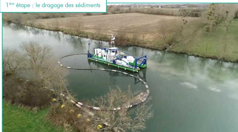
2<sup>ème</sup> étape : transport de la mixture eau + sédiments vers le site de décantation
