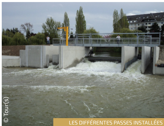
LES DIFFÉRENTES PASSES INSTALLÉES
