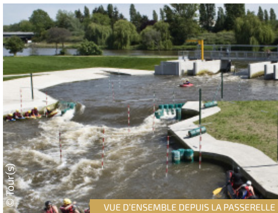
VUE D'ENSEMBLE DEPUIS LA PASSERELLE
