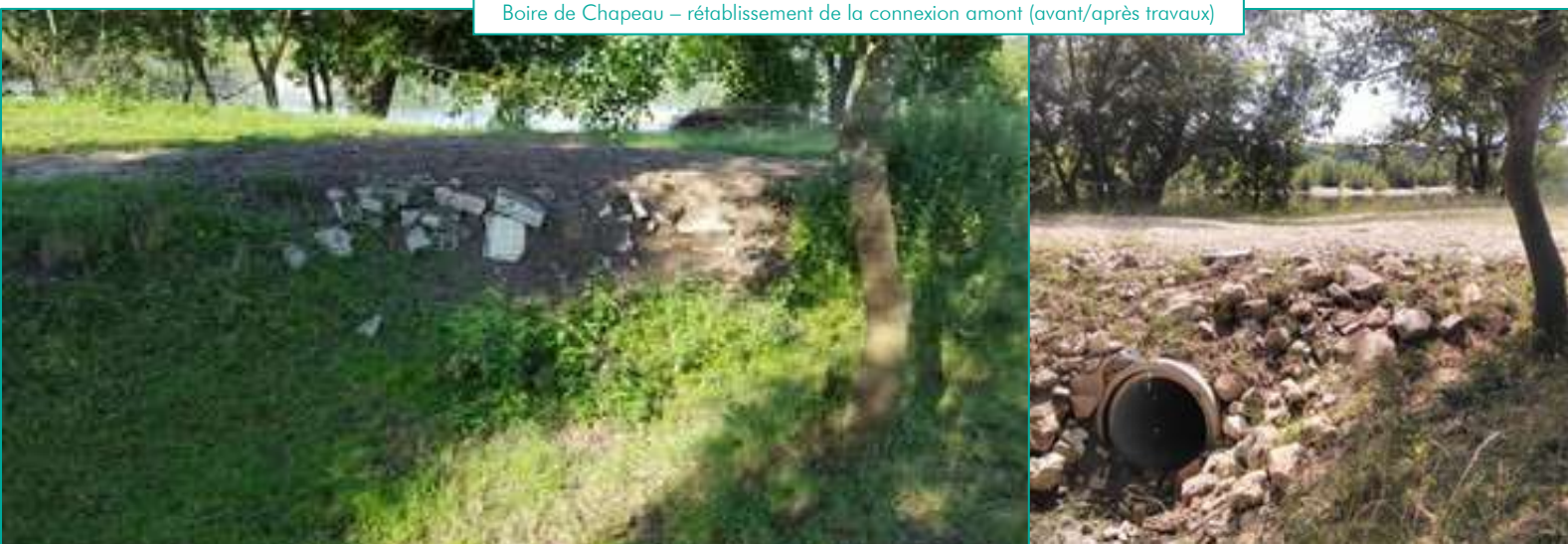
Boire de Chapeau – rétablissement de la connexion amont (avant/après travaux)
