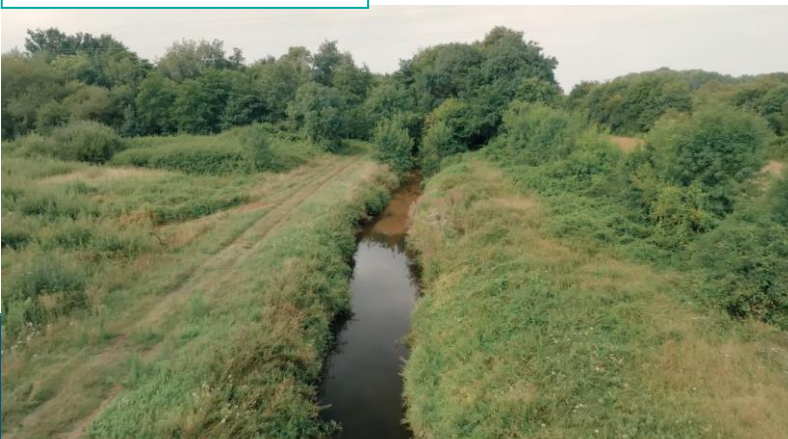
Tronçon2 - Ancien profil de la Jalle
