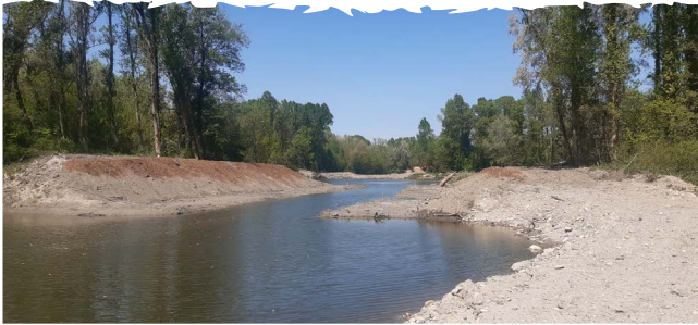
Site durant les travaux, début 2022
