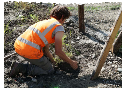
4 Pose des enclos de protection et plantation de roseaux
