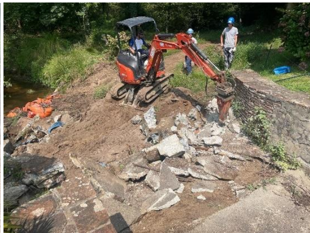
Photos pendant travaux, découpage seuil béton
