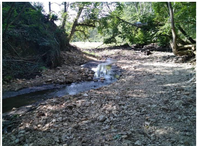
Photo après travaux à l'emplacement du déversoir
