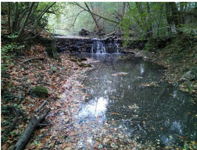
Photo du déversoir avant travaux
