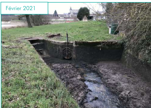
Remise à ciel ouvert et reméandrage du cours du Saint-Bonifet (phase 2)
