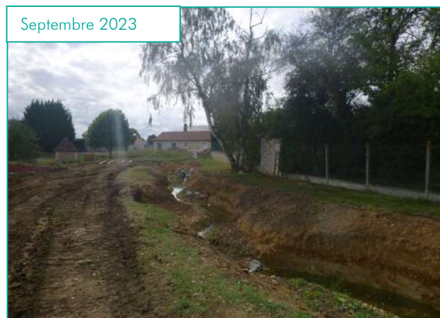
Remise à ciel ouvert et reméandrage du cours du Saint-Bonifet (phase 2)
