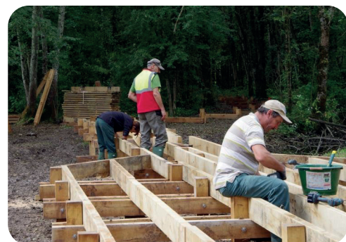
3 Construction du sentier sur pilotis
