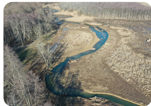
1 Travaux de réhabilitation environnementale des Rousses
