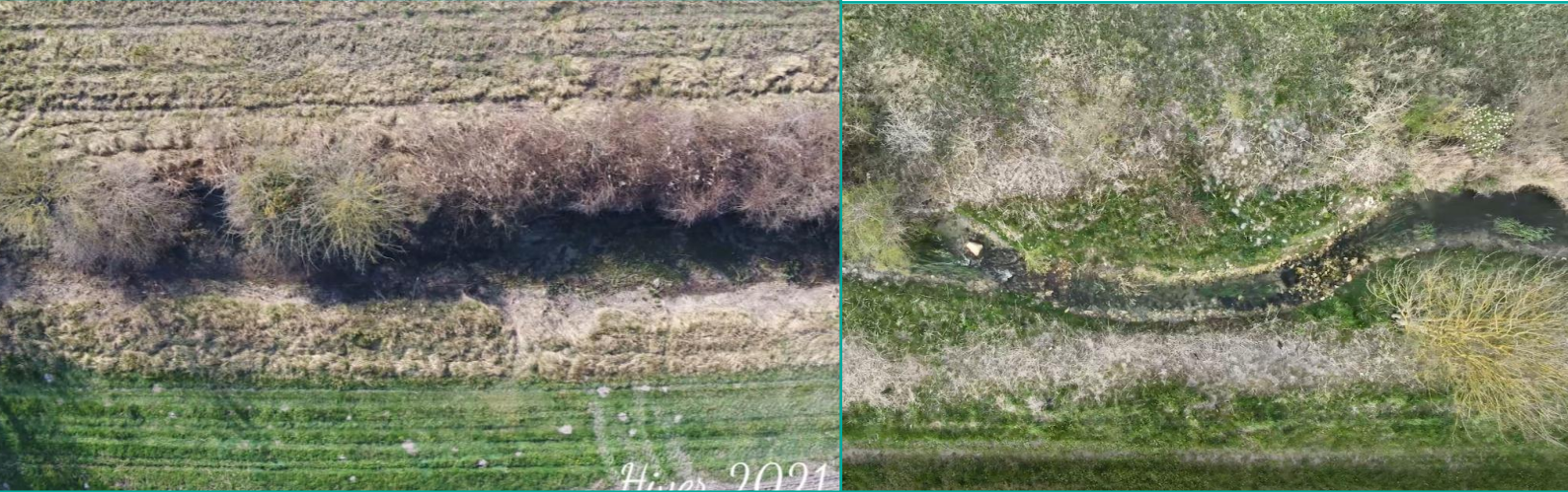
Vue aérienne du tracé de la Divise avant et après les travaux
